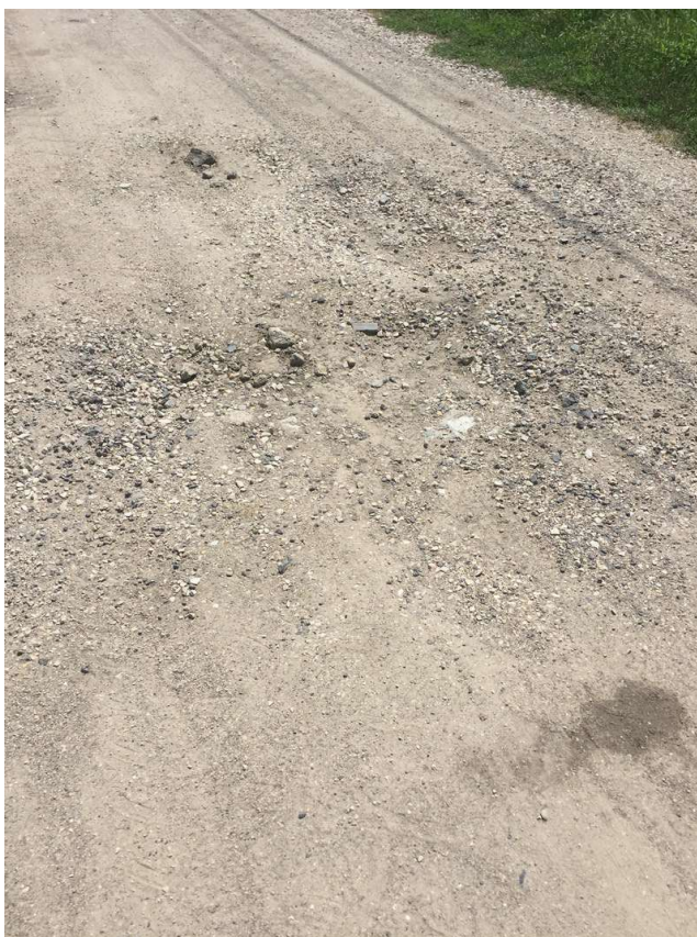
Lokálisan kimosódott útpálya
