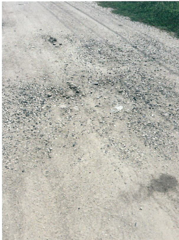
Lokálisan kimosódott útpálya
